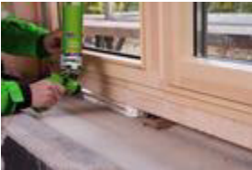
Verarbeitung des Fensteranschlusses mit FM230.
