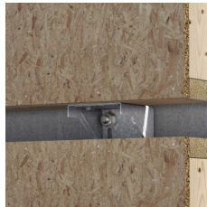
Holzkonstruktion unter dem Konsolwinkel an der Deckenschmalseite.
