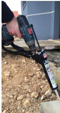
Anwendung mit Injektionsmörtel
