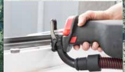
Die Säbelsäge ist perfekt dazu geeignet, um alte Fensterrahmen verschiedenster Bauarten einzusägen und zu demontieren.
