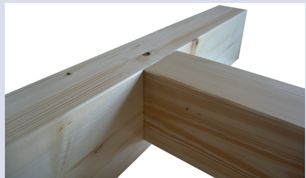
Fräsung nachträglich verschlossen
