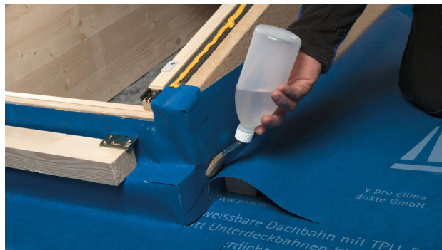
20. Unteren Eckbereich verschweißen.
