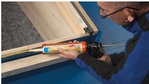
7. ORCON CLASSIC Raupe mit mind. 6 mm Durchmesser auf mineralischen Untergrund auftragen (bei rauen Untergründen ggf. mehr) und SOLITEX WELDANO-S 3000 an der Unterseite des Fensterrahmens ankleben.
