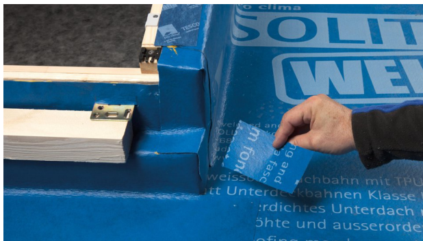
27. Um Schnittkanten im unteren Eckbereich zu überdecken, einen kleinen Streifen SOLITEX WELDANO 3000 ausschneiden und anlegen.
