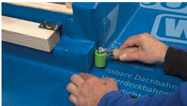
29. SOLITEX WELDANO 3000 Streifen anschweißen.
