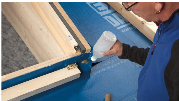
9. Zuvor gefaltete Ecke verschweißen.
