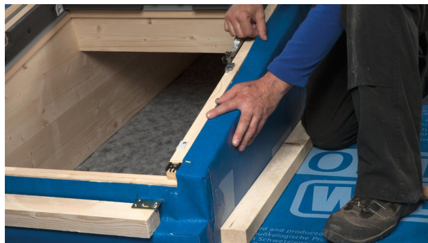
22. SOLITEX WELDANO 3000 entlang der Rahmenkante verkleben. Bahn mit Dehnschlaufe in das Kleberbett legen. Kleber dabei nicht ganz flach drücken, damit ggf. Bewegungen aufgenommen werden können.
