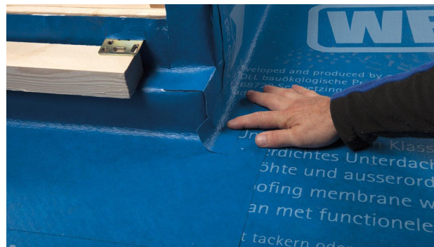
28. Auf wasserführende Bahnenüberlappung achten.
