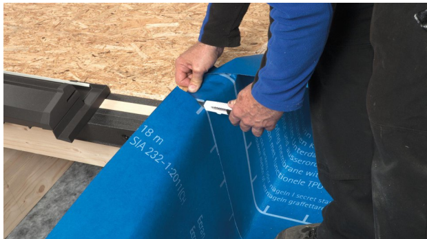
17. Seitlich am Aufkeilrahmen die Bahn aus der Fläche hochführen. Alternativ einen neuen Streifen SOLITEX WELDANO 3000 ablängen, am Aufkeilrahmen hochführen und unten auf der flächigen Bahn schweißen.
