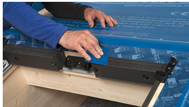
26. TESCO VANA zur praktischen Montage-Fixierung verwenden.
