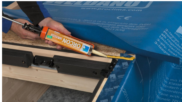
24. Flächige SOLITEX WELDANO 3000 mit ORCON CLASSIC am oberen Fensterrahmen verkleben.
