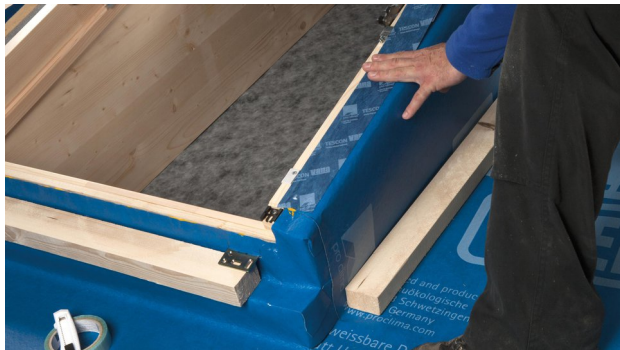
23. TESCON VANA zur praktischen Montage-Fixierung verwenden.
