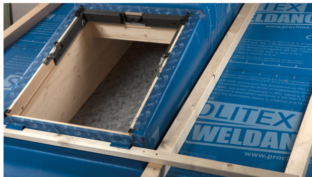
34. Konterlatten und Traglatten montieren und Montagewinkel verschrauben. Fertig.
