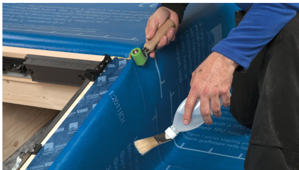
25. Seitlich die Lagen SOLITEX WELDANO 3000 miteinander verschweißen.
