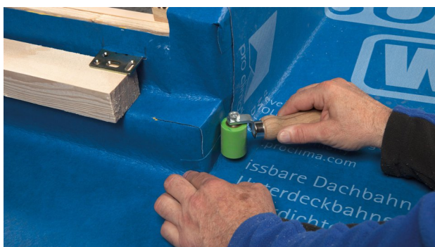
29. SOLITEX WELDANO 3000 Streifen anschweißen.
