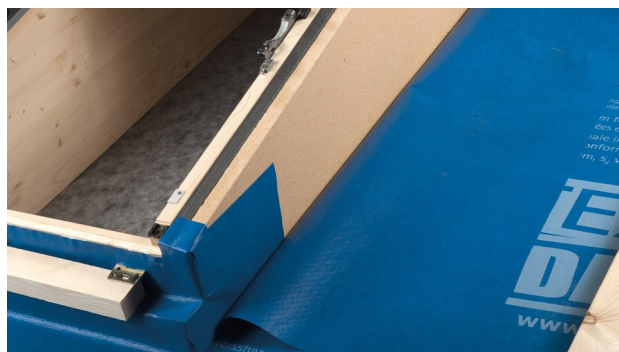
16. Fertige untere Eckabdichtung.
