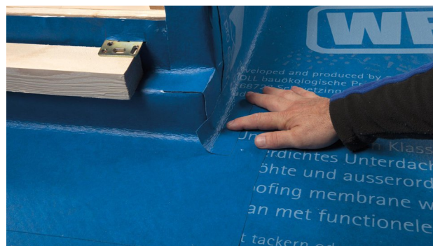
28. Auf wasserführende Bahnenüberlappung achten.
