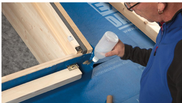
9. Zuvor gefaltete Ecke verschweißen.
