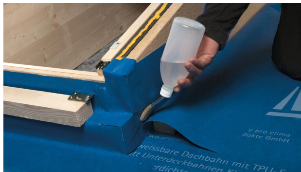
20. Unteren Eckbereich verschweißen.
