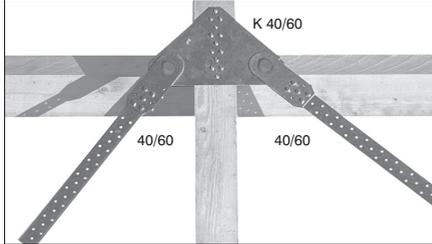
Der Bandanschluss K 40/60 ist hier mit 2 St. Kopplungsverbindern 40/60, zur Aufnahme des Windrispenbandes 40 x 2,0, im Firstbereich eingebaut. Er wird auf der Oberseite des Sparrens mit CNA4,0x40 Kammnägeln oder CSA5,0x35 Schrauben befestigt. Der Sparren wird separat auf der Firstpfette befestigt.
