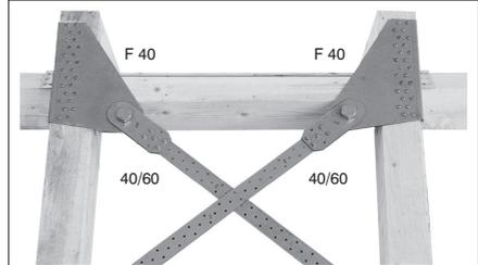
Die Bandanschlüsse F 40 sind hier mit Kopplungsverbindern 40/60, zur Aufnahme des Windrispenbandes 40 x 2,0, im Firstbereich eingebaut. Sie werden auf der Oberseite der Sparren mit CNA4,0x40 Kammnägeln oder CSA5,0x35 Schrauben befestigt. Zwischen den Sparren ist ein Füllholz mit Balkenschuhe eingebaut. Die Sparren werden separat auf der Firstpfette befestigt.
