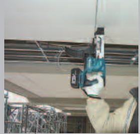
**Gummierte Aufsetzfläche verhindert das Abrutschen von glatten Oberflächen**
