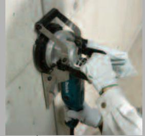
**Metalleinschlüsse in Beton wie Nägel, Bindedraht usw. werden ohne Beschädigung der Scheibe weggeschliffen**
