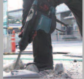
Durch die aktive wechselseitige Zwangsteuerung eines Kontergewichtes mittels Luftdruck werden Massenträgheitsmomente, die durch Schlagwerk sowie Einsatzwerkzeug entstehen und zu unerwünschten Vibrationen führen, wirkungsvoll minimiert
