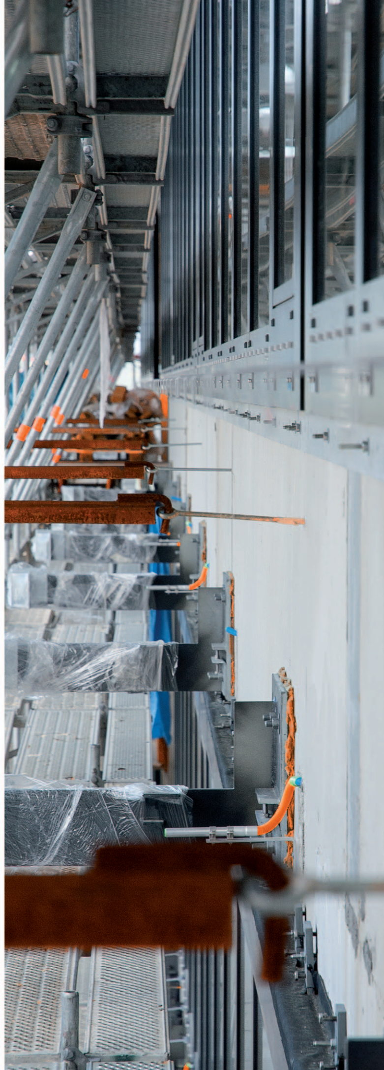
Einbautiefenmarkierung Zur Kontrolle der Einschraubtiefe.
